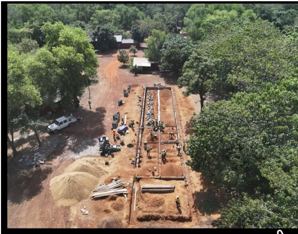
Figure 8 construction des logements pour les travailleurs
