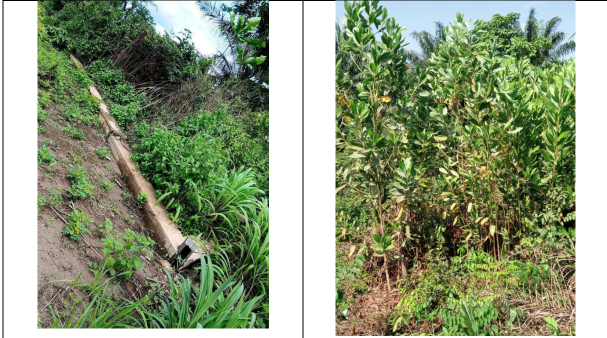
Figure 10. Illustrations des biens affectés dans la zone du projet : à gauche, fondation Impactée et à droite, cultures affectées
