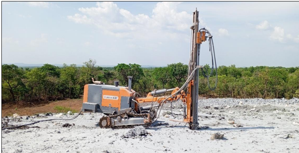
Photo 3 : Illustration du type de foreuse prévu pour la réalisation des trous de mine
