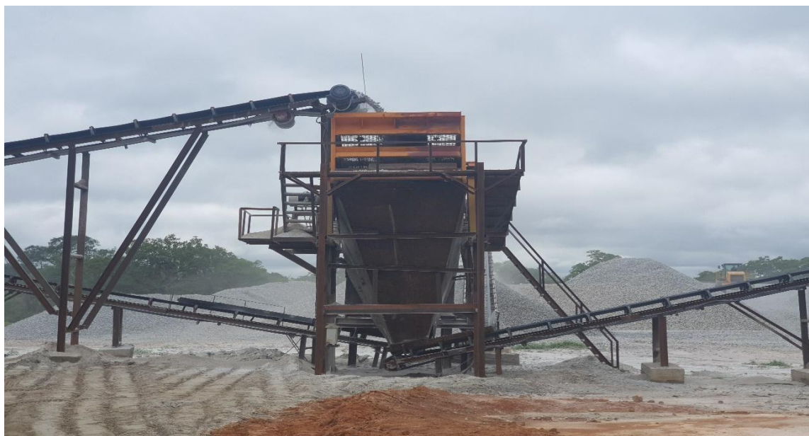
Source : Carrière de granite de CHINO AFRICA INTERNATIONAL SARL, Juillet 2023
